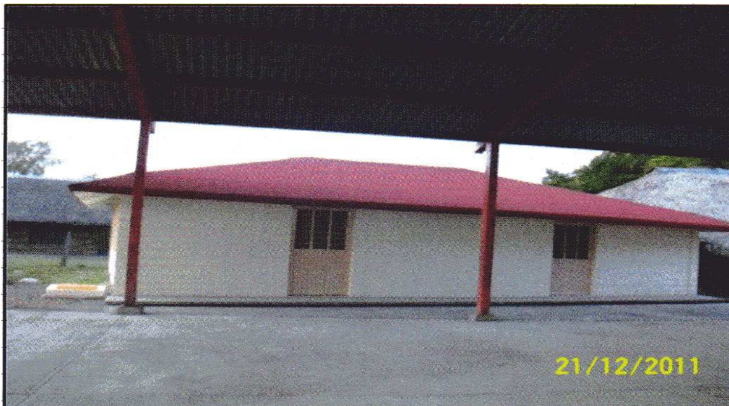
CENTRO DE ACOPIO Y COMERCIALIZACION DE MERCANCIAS DIVERSAS DE LA REGION EJIDO SAN JUAN DE LAS VEGAS SAN VICENTE TANCUAYALAB, S.L.P.,
